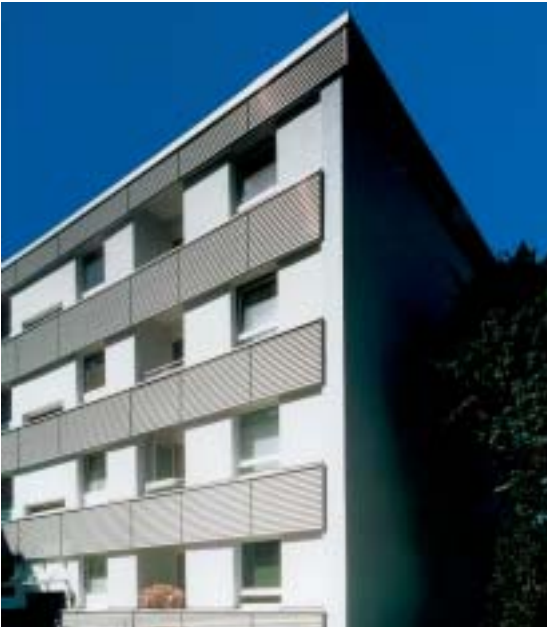
Beispiel Welle: Die durchgehend horizontal verlaufende Wellenstruktur gibt dem Gebäude einen neuen Charakter.
